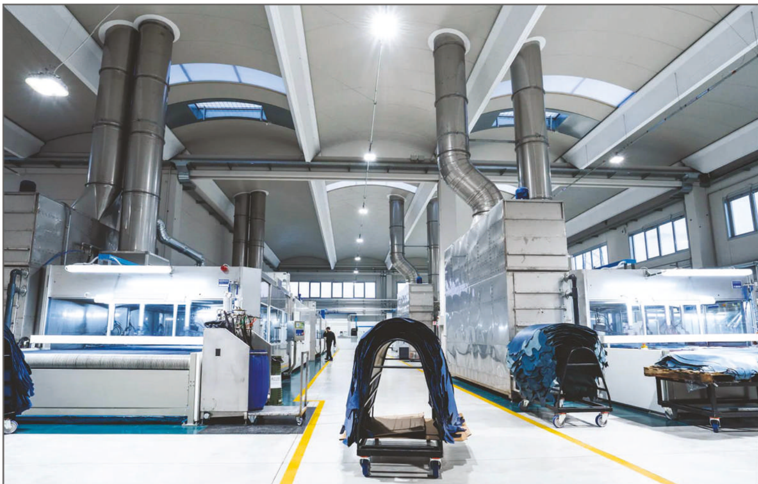
Reparto rifinizione dello stabilimento di Castelfranco di Sotto, via dell'Ippocastano 14-22
